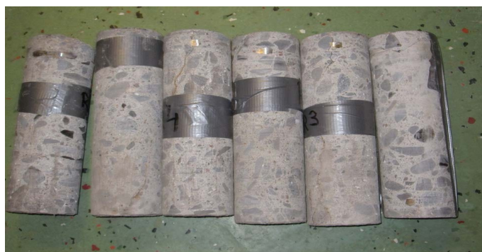
Borrkärnor har tagits ut för att undersöka betongens kondition.
