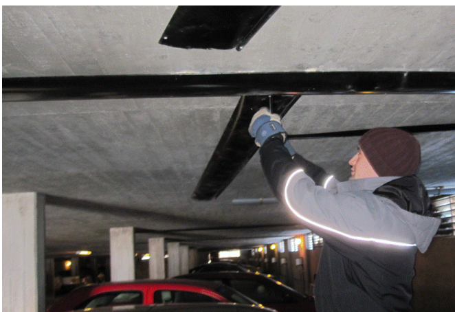
Vatten tränger in och försvagar betongen. Kalkurlagningar kan skada lacken på bilarna.
